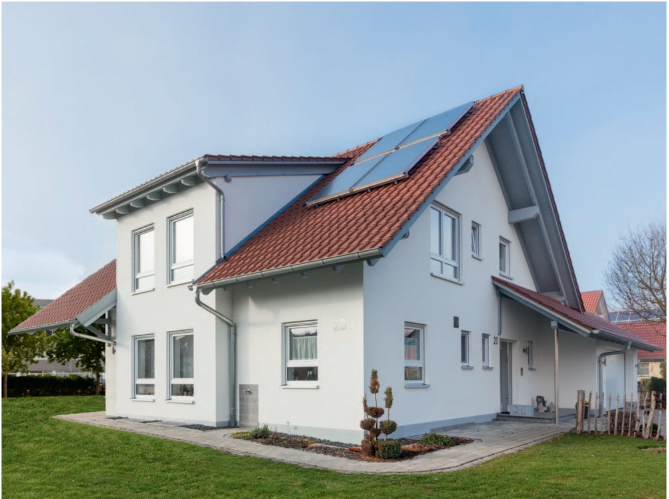
Zonne-installatie voor de bereiding van sanitair warm water en verwarmingsondersteuning
