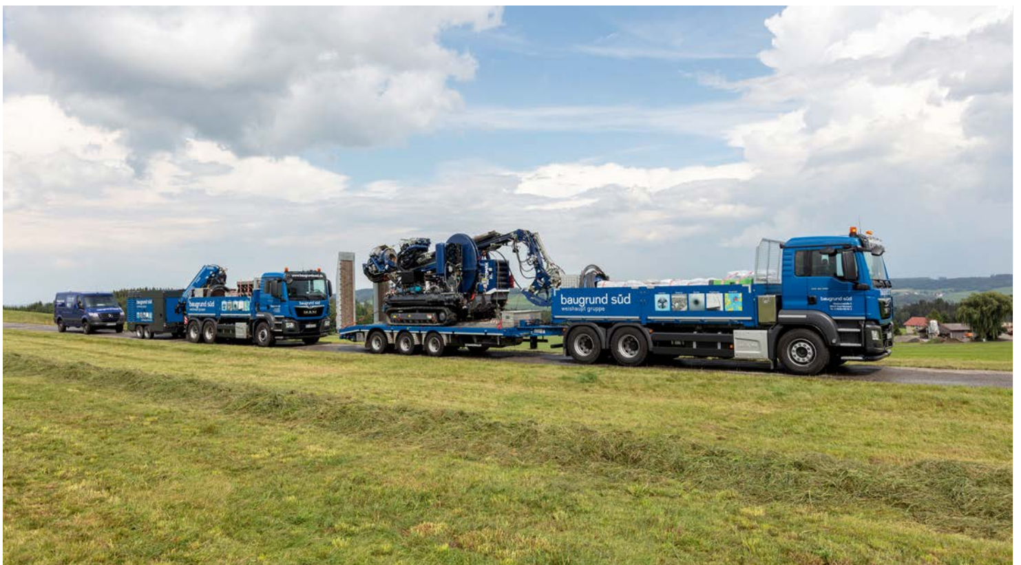
BauGrund Süd beschikt over een ervaring van meer dan 22.500 installaties en meer dan 3 miljoen boormeters.
