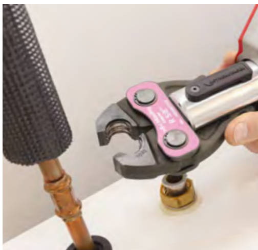
3. Gereedschap correct positioneren
